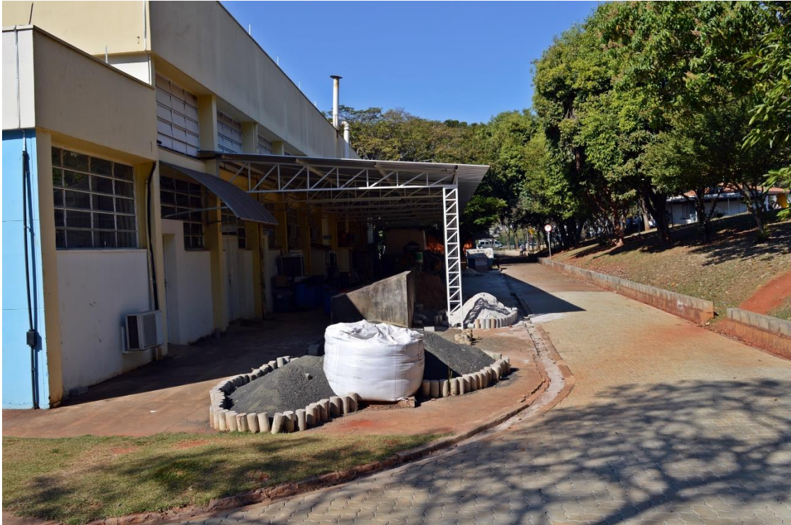
Figura 12 - Ampliação da cobertura externa dos Laboratórios (Materiais de Construção Civil e Solos e Pavimentação)
