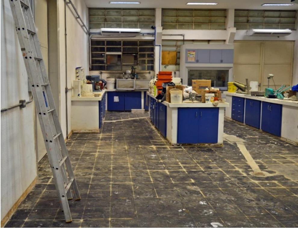
Figura 13 - Laboratório de Materiais de Construção - Adequações das instalações hidráulicas e remoção do antigo piso.
