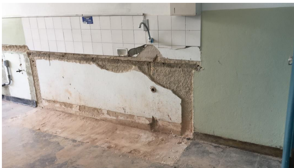
Figura 1 - Início das obras da cozinha
