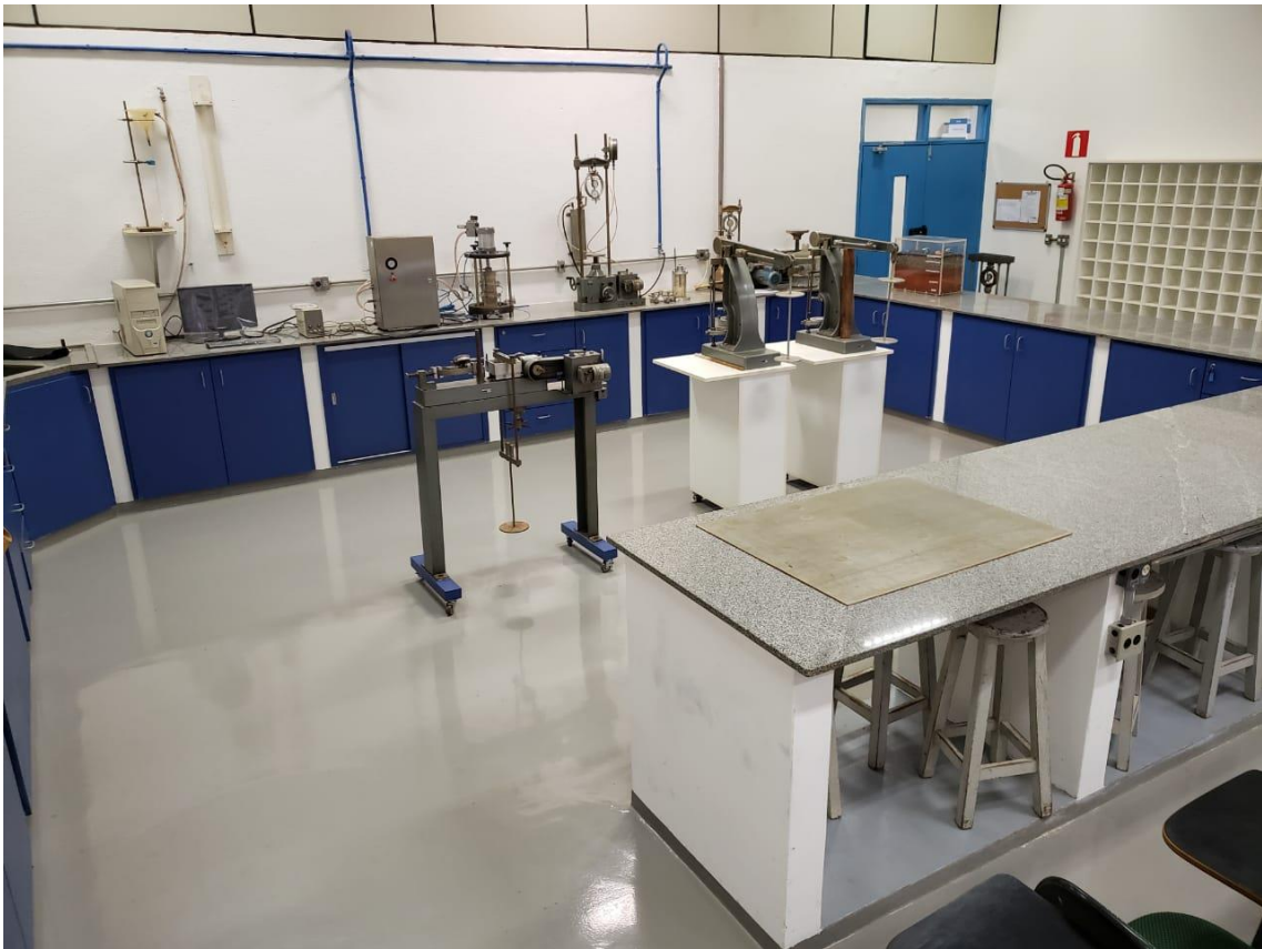
Figura 17 - Laboratório de Solos e Pavimentação – Novo piso industrial, pintura e instalação de novos aparelhos de ar-condicionado.
