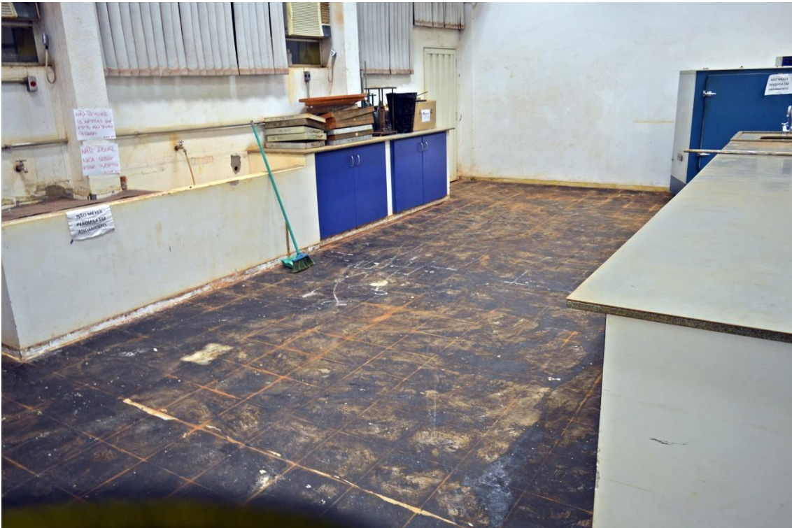
Figura 16 - Laboratório de Solos e Pavimentação – Remoção do Paviflex antigo
