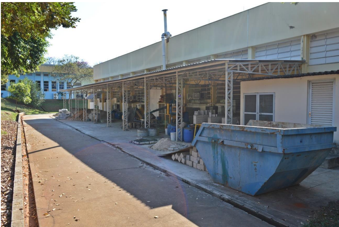
Figura 11 - Ampliação da cobertura externa dos Laboratórios (Materiais de Construção Civil e Solos e Pavimentação), totalizando 10 pilares
