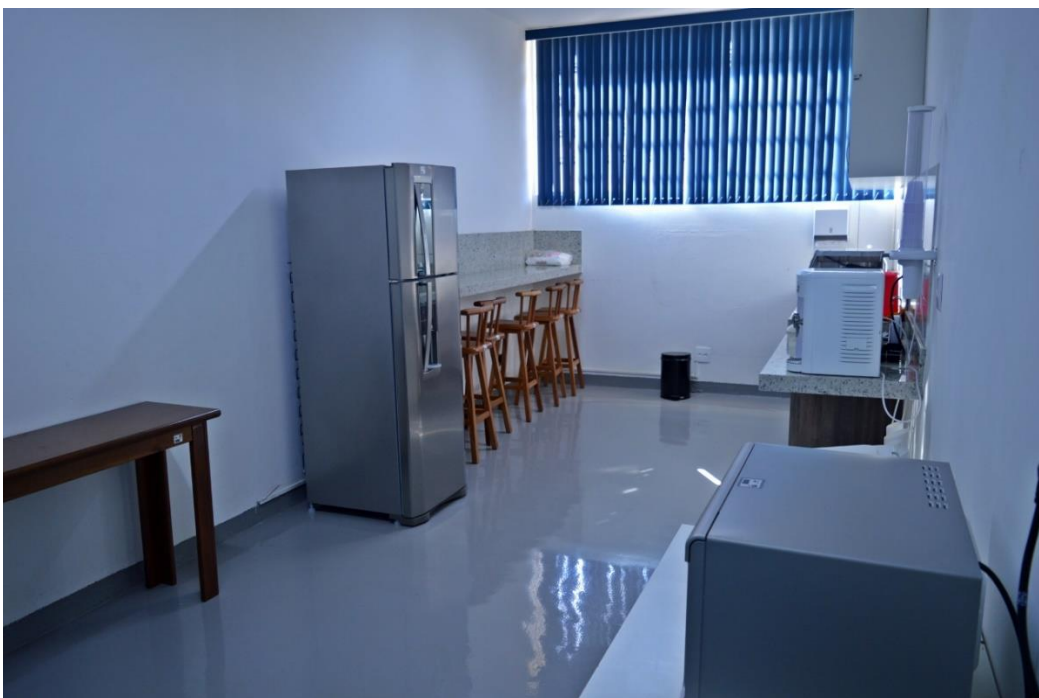
Figura 2 - Cozinha após a reforma.
