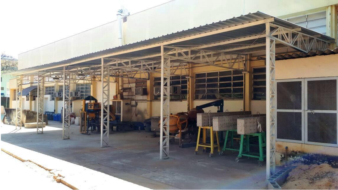
Figura 10 - Cobertura externa do Laboratórios (6 pilares)
