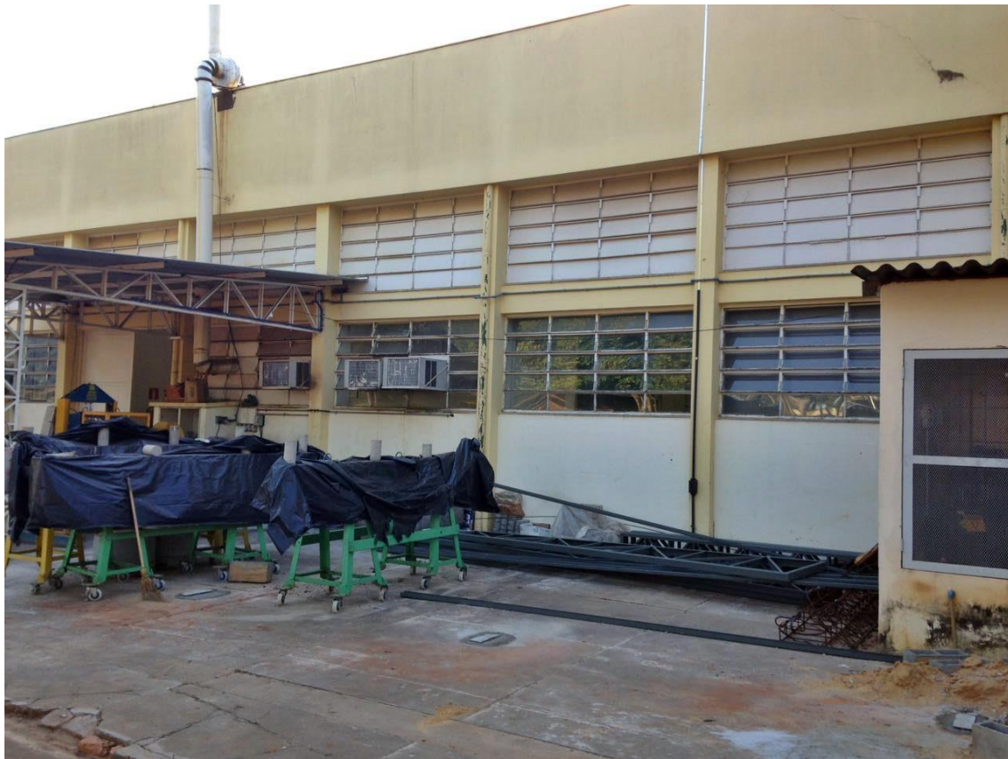
Figura 14 - Antiga cobertura externa do Laboratório de Materiais
