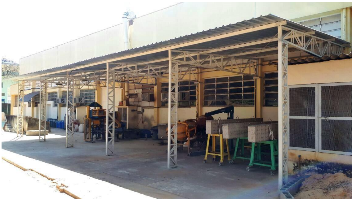
Figura 15 - Atual cobertura externa do Laboratório de Materiais (ampliada)
